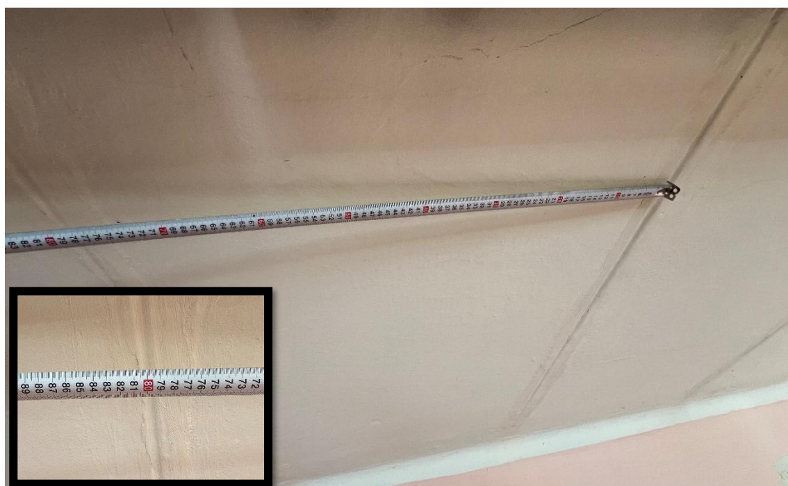
8 pav. Denginio plokštės pločio matavimas
